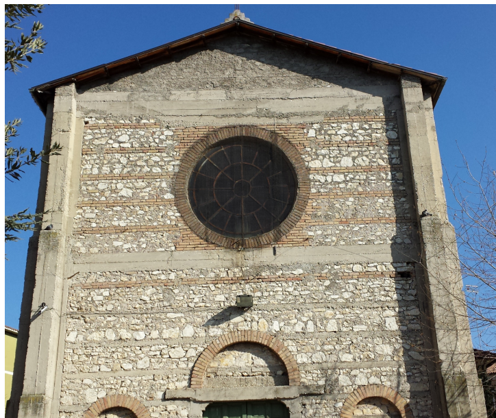
Prospetto principale su giardino pubblico
