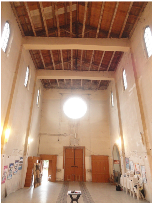
Vista generale degli ambienti interni
