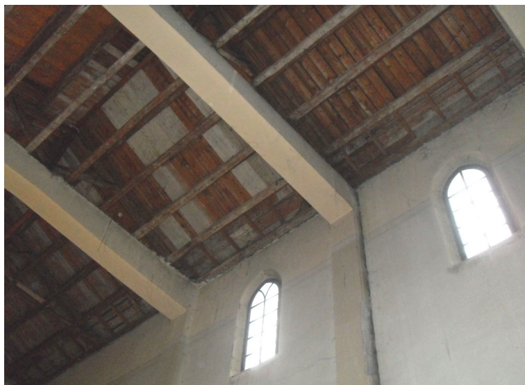
Vista generale delle strutture in cemento armato
