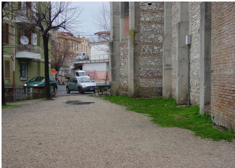
Area di accesso al cantiere tra via Umberto I e via Liberata
