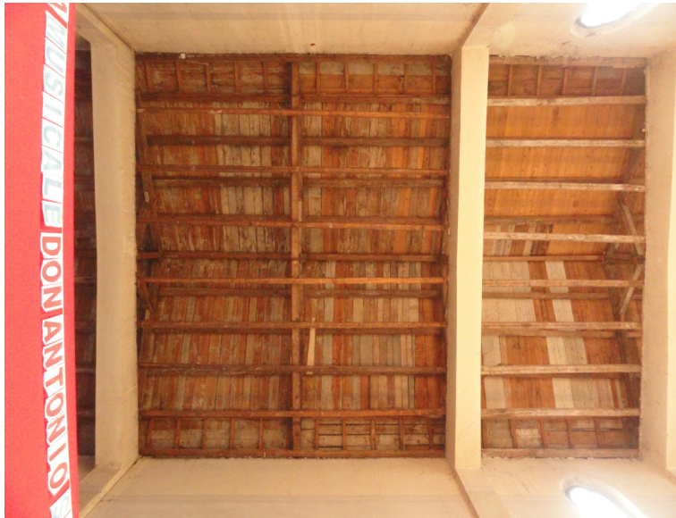
Vista generale del sistema di copertura ligneo esistente
